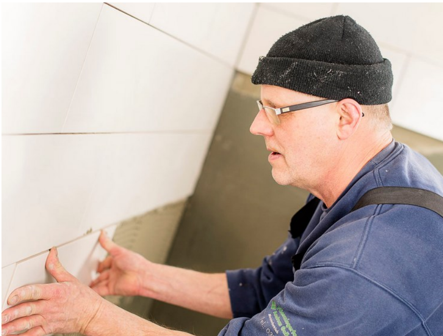
Die Fliesenleger sind bereits fleißig bei der Arbeit
