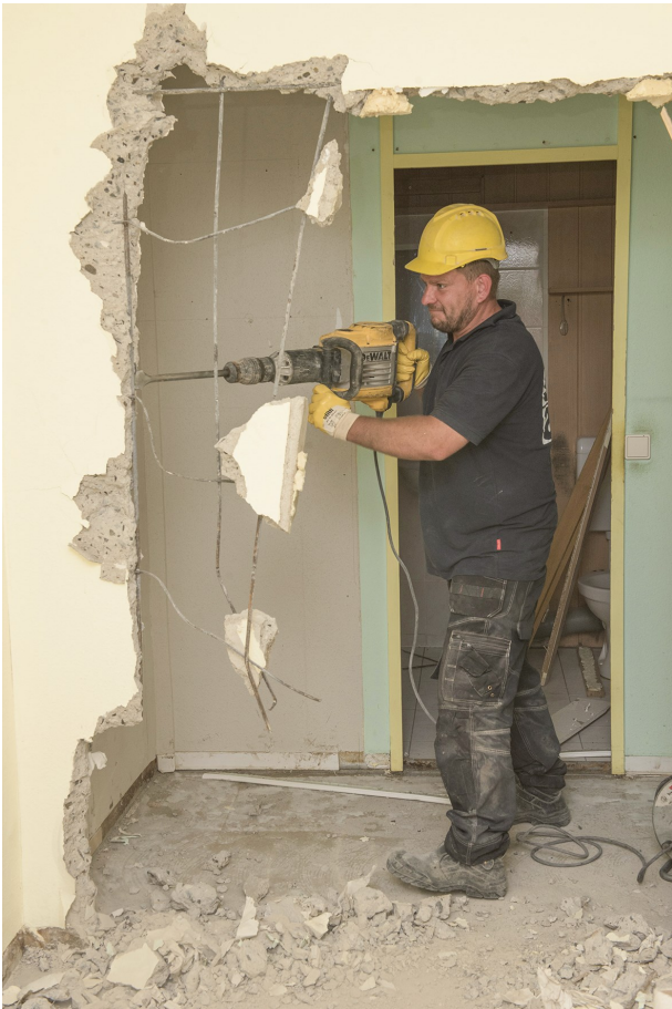
Der Fünfgeschosser in der Neubrandenburger Straße 1, 3, 5 und 7 wird aufwändig saniert. Mit dem Stemmhammer sind die Handwerker bereits aktiv
