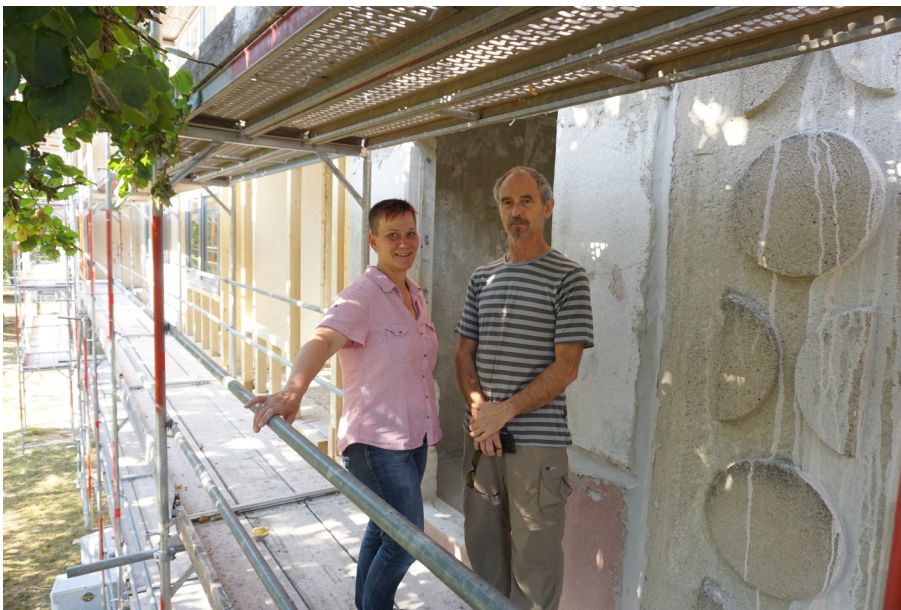
WGS-Projektleiterin Martina Hartnuß und Bauleiter Erich Kästner vom Ingenieurbüro BBB machen das Haus bis November winterfest
