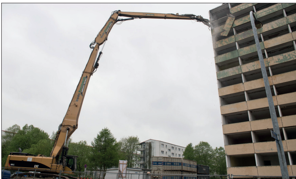
Mit 350 Bar Beißkraft trennte der Longfront-Bagger die ersten Platten vom Dach des Hochhauses und leitete damit den Abbruch des zweiten Lankower Hochhauses ein
